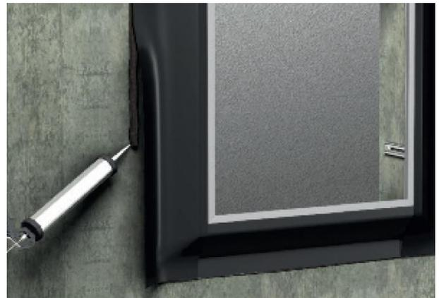
TEROSON AD KDS FR mit der Hand- oder Druckluftpistole (Luftdruck 0,5 bis 5 bar) streifenförmig auf den Untergrund auftragen.
